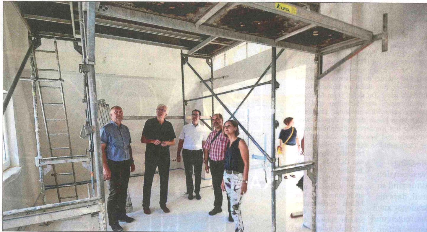
Die grundlegenden Arbeiten sind erledigt. Jetzt geht es noch an den Feinschliff im Genkinger-Haus.
