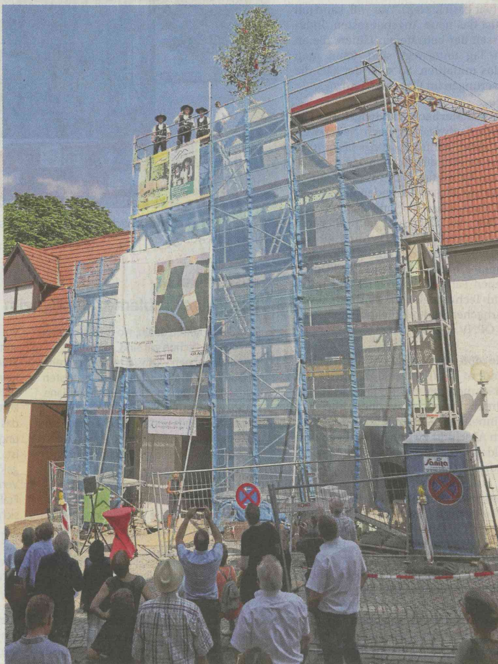
Vor sieben Monaten fiel der Startschuss für den Umbau des historischen Gebäudes am Göckelhof zum Fritz-Genkinger-Kunsthause. Gestern wurde Richtfest gefeiert.
